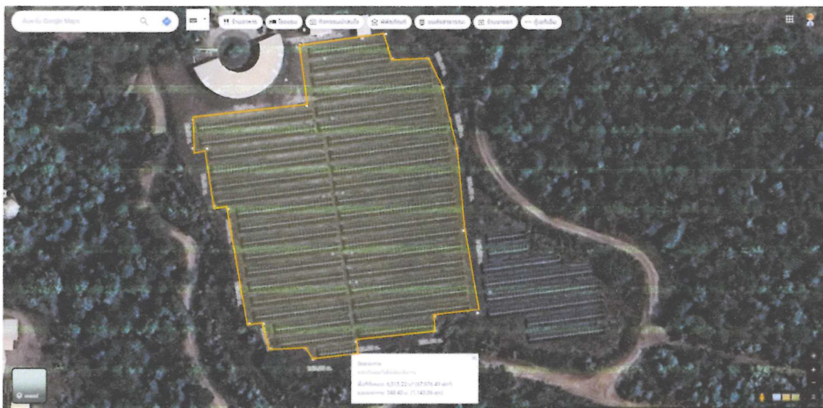
รูปภาพ 1 ภาพมุมสูงของระบบผลิตไฟฟ้าจากพลังงานแสงอาทิตย์ ขนาด 702 กิโลวัตต์ ส่วนที่ 1 (ส่วนบน)
